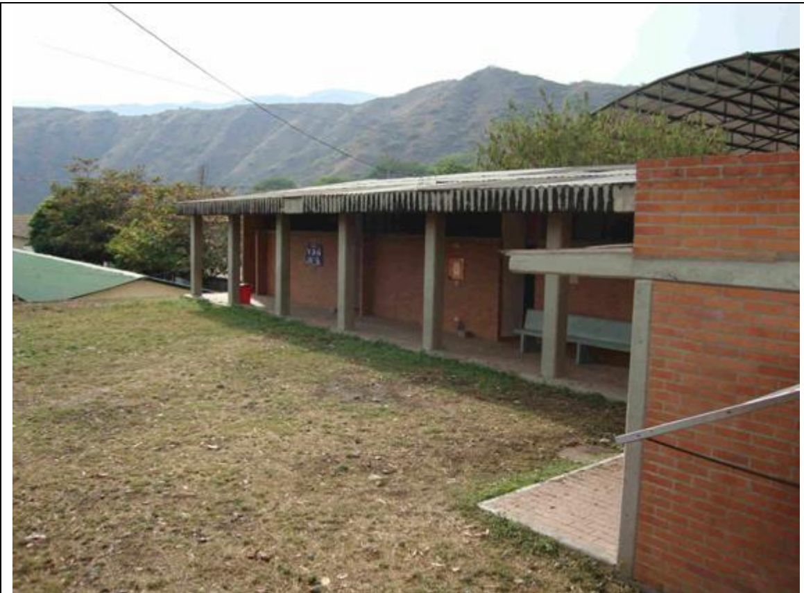
Plazoleta del auditorio, requiere adecuación
