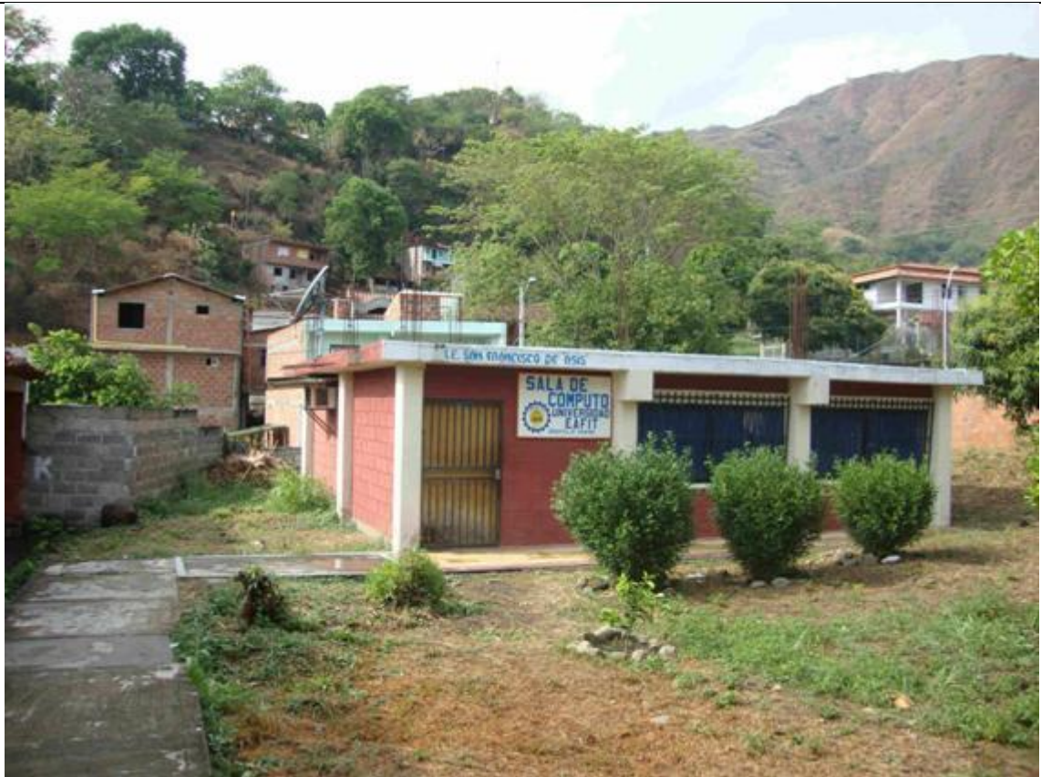
Actual Aula de cómputo, la plancha deja pasar la humedad
