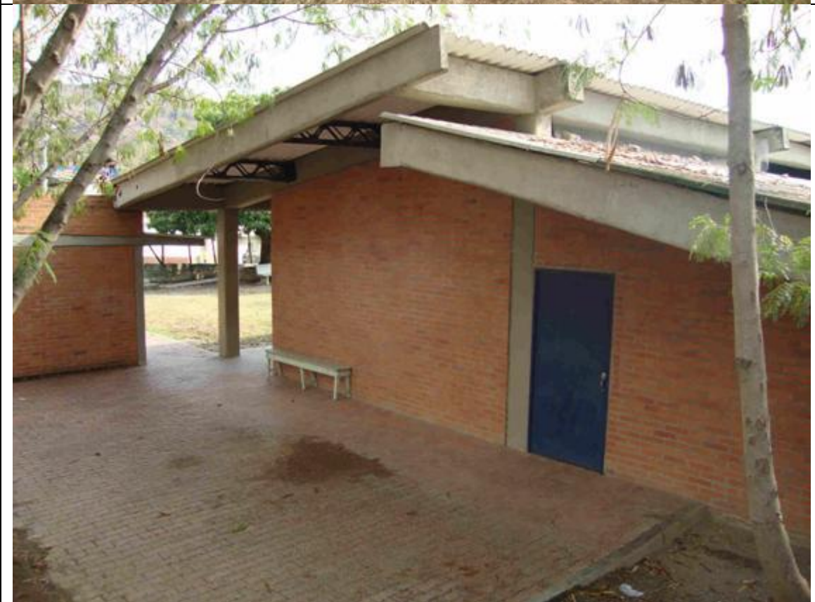
Espacio propicio para la adecuación del Auditorio para actividades institucionales y de servicio comunitario.
