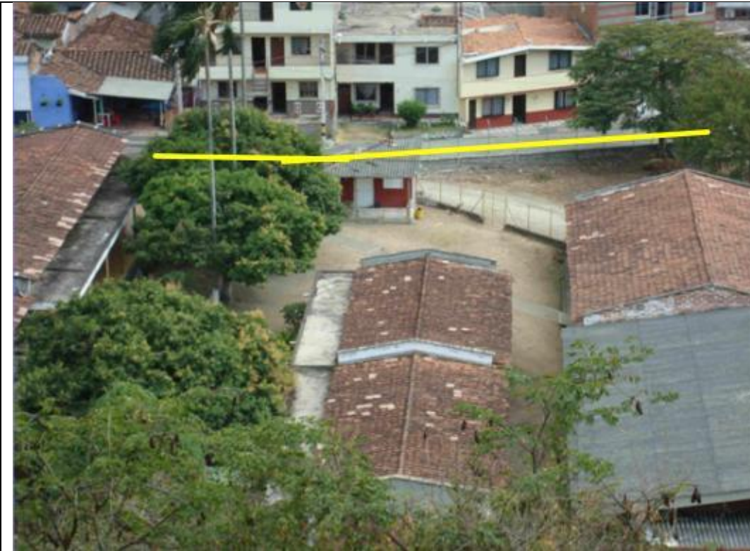
Unificación de la institución
